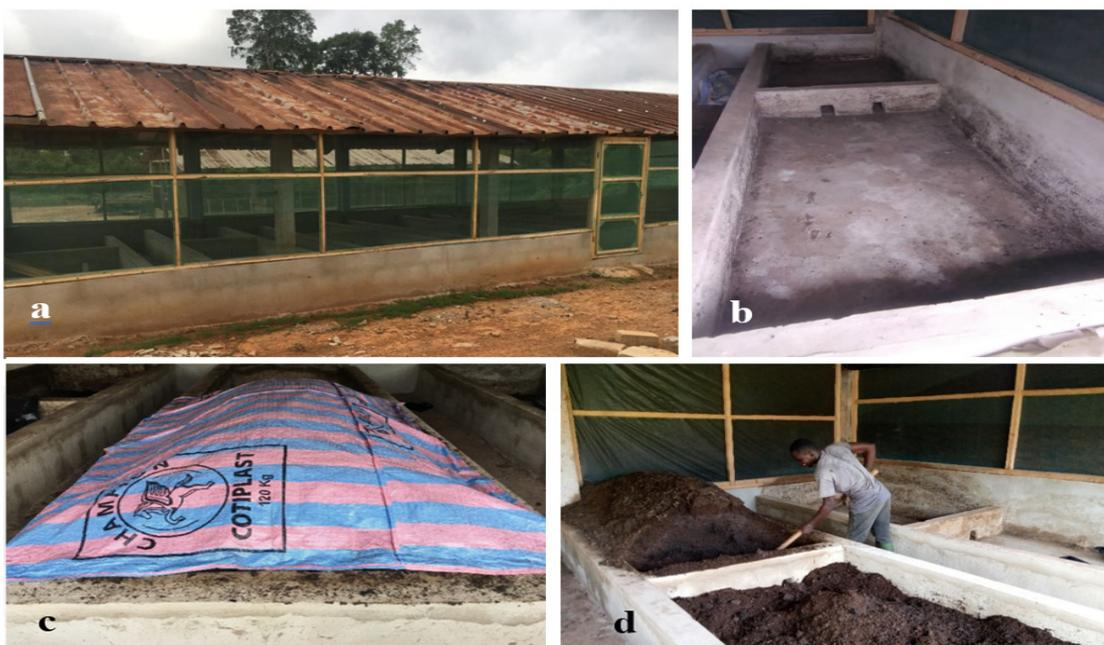
Figure 2: Plate-forme de compostage (a), barques en brique (b), andain recouvert d'une bâche en polypropylène (c), retournement d'un compost d'une barque à une autre (d)
